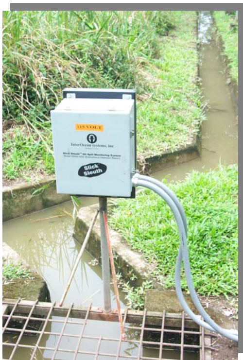
製油所構内排水溝
