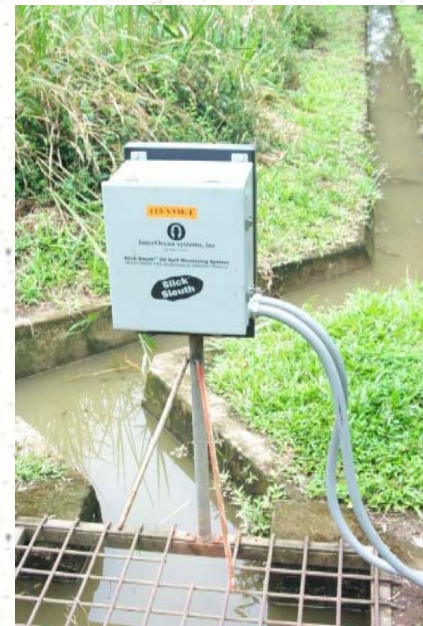
製油所構内排水溝
