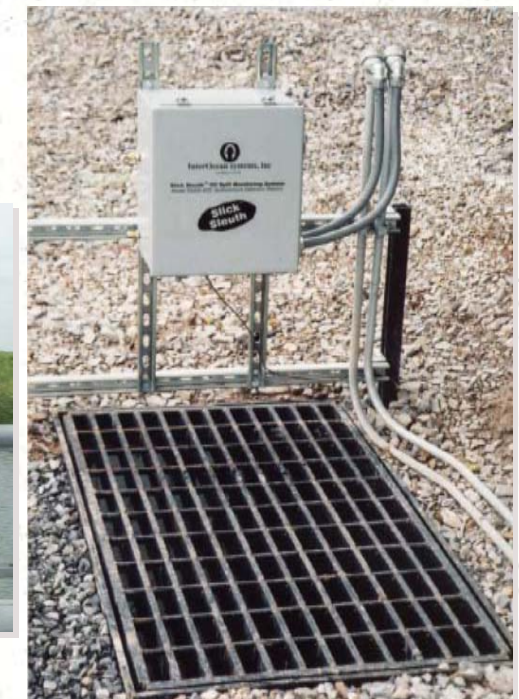
自動検出・自動ポンプ遮断システム
